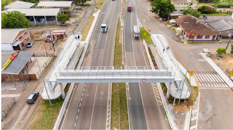
Vista Superior da passarela BR-386- km 388+360(SNV) 386+550(PER).
