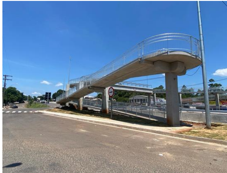
Vista inferior da passarela BR-386- km 388+360(SNV) 386+550(PER).
