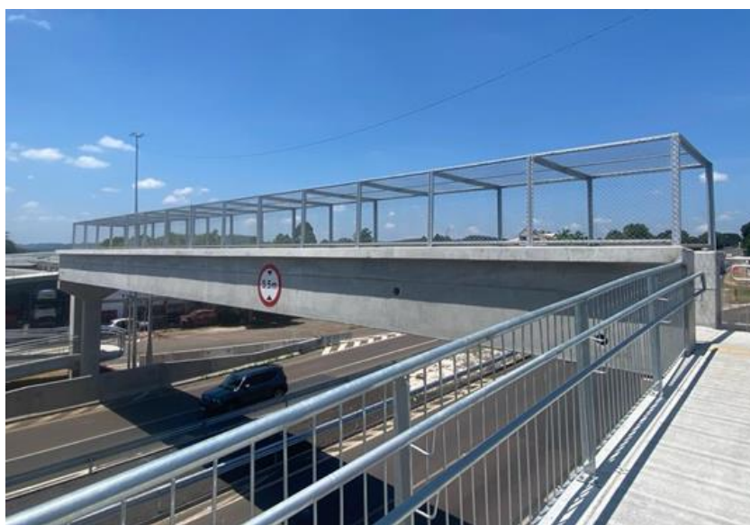
Vista frontal da passarela BR-386- km 388+360(SNV) 386+550(PER).
