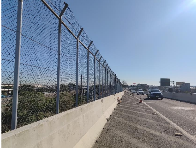
Vista geral recuperação da OAE km 091+850 (PER) Oeste.
