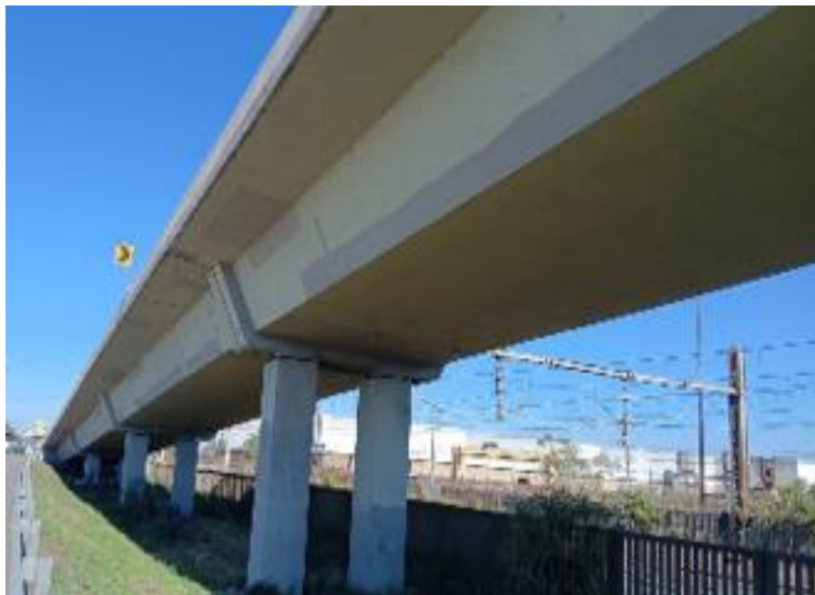
Vista inferior da recuperação da OAE km 091+850 (PER) Oeste.
