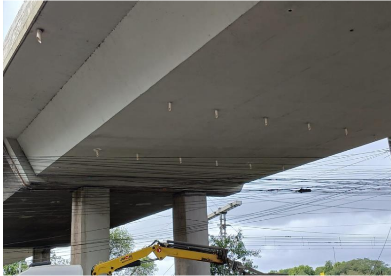
Vista inferior da recuperação OAE km 091+850 (PER) Oeste.
