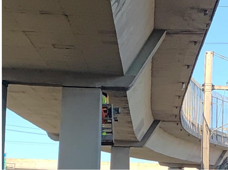
Vista geral recuperação da OAE km 091+850 (PER).
