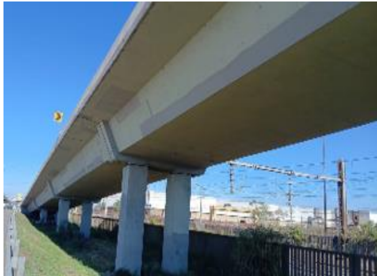
Vista inferior da recuperação da OAE km 091+850 (PER).
