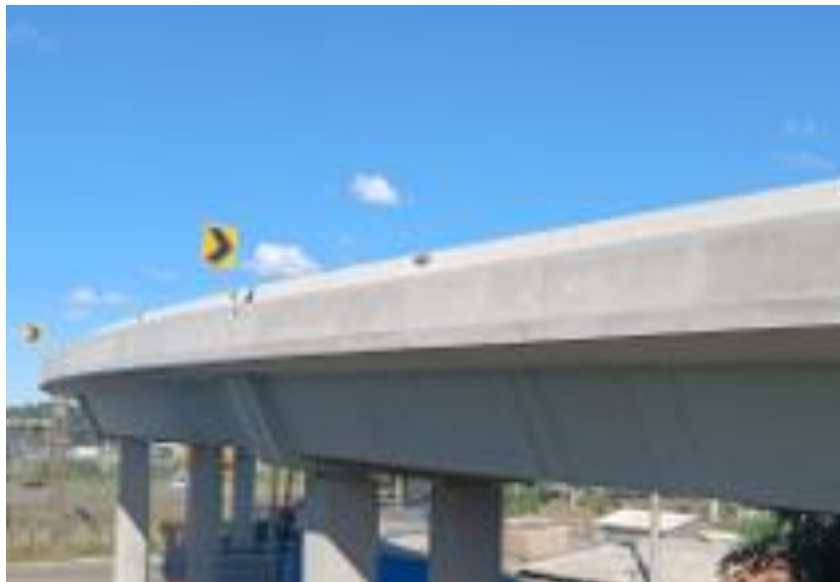
Vista geral recuperação da OAE km 091+850 (PER).
