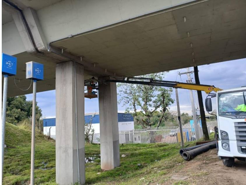
Vista inferior da recuperação OAE km 091+850 (PER).
