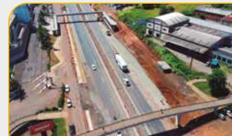
Para isso, foram utilizadas cerca de 2,1 toneladas de explosivos. Conforme a Concessionária, as detonações nesses locais foram necessárias para promover a implantação dos sistemas de drenagem e camadas mais profundas do futuro pavimento, já em andamento.
