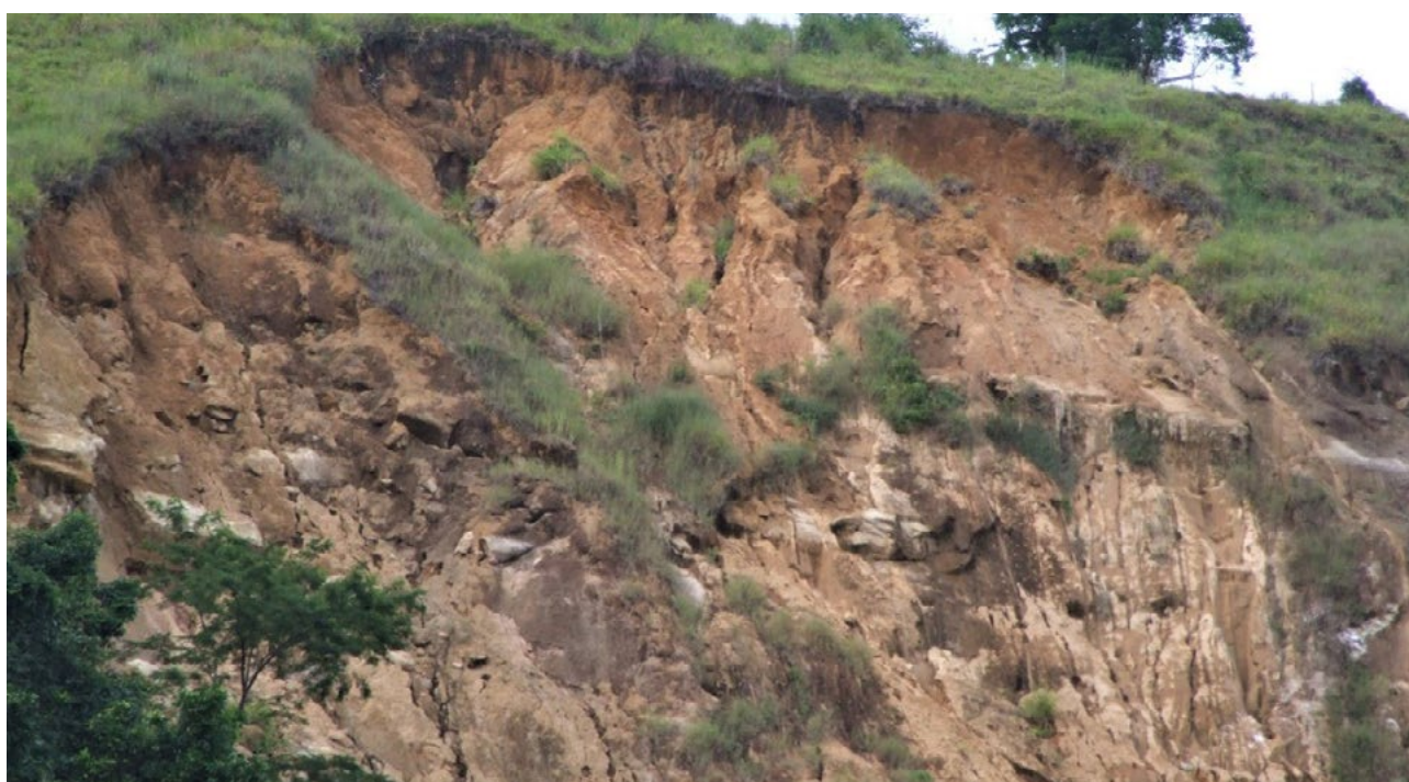
Solo areno-argiloso a argiloso espesso (Latosolos) e solo de alteração areno-silto argiloso com blocos de rocha, afetado por erosão laminar e em sulco de alta intensidade, que ocorrem sobre material escorregado
