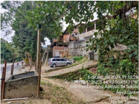
Km 470+000 m, entrada do bairro Água Santa (Angra dos Reis/RJ).
