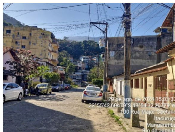
Condições das habitações no bairro Itacuruçá (Mangaratiba/RJ).
