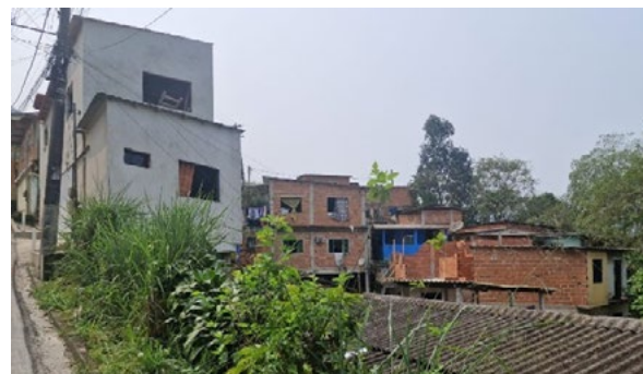
Condições das habitações no bairro Gamboa do Belém (Angra dos Reis/RJ).
