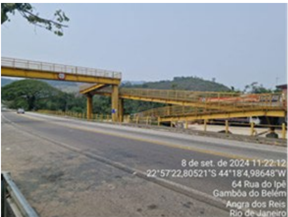
Km 488+900 m, entrada do bairro Gamboa do Belém (Angra dos Reis/RJ).
