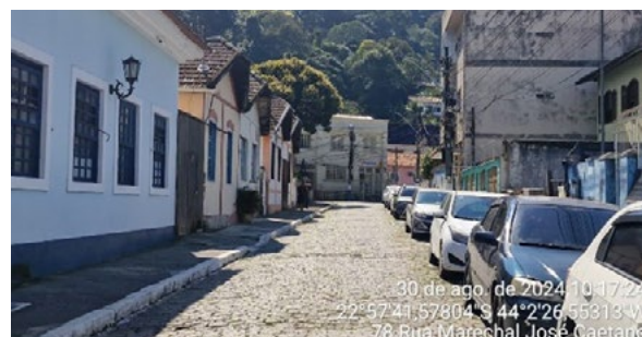
Condições das habitações no bairro Praia do Saco (Mangaratiba/RJ).
