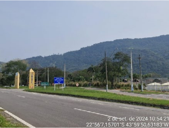
Alça de acesso da BR-101/RJ para a Avenida Vale do Sahy e Estrada Fazenda Santa Bárbara, Mangaratiba/RJ (km 428).
