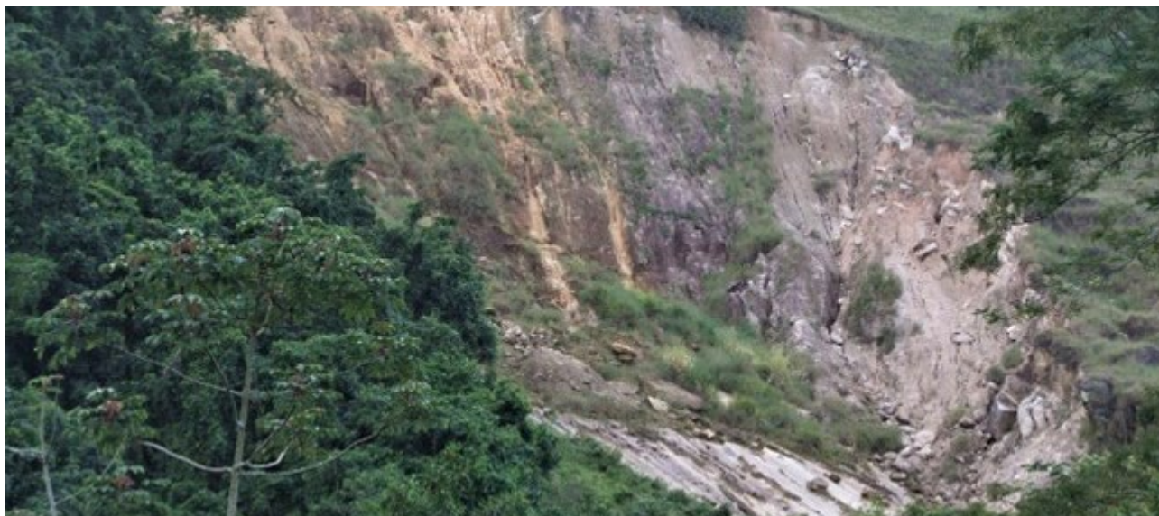
Escorregamento profundo com superfície de ruptura solo de alteração. (Coordenadas 23K 582514/7452875)
