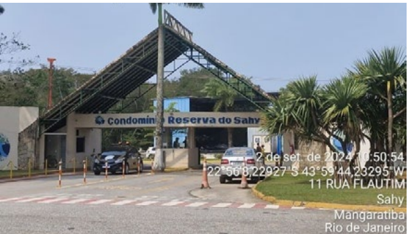
Km 427+900 m, entrada do Condomínio Reserva do Sahy (Mangaratiba/RJ).
